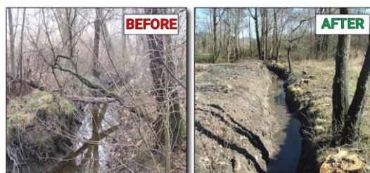
Figura 1. Esempio di semplici lavori di manutenzione (Pulizia di un fosso).
